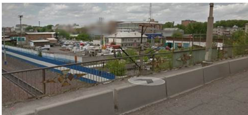
Рис. 5. Фото участка с металлическим экраном
