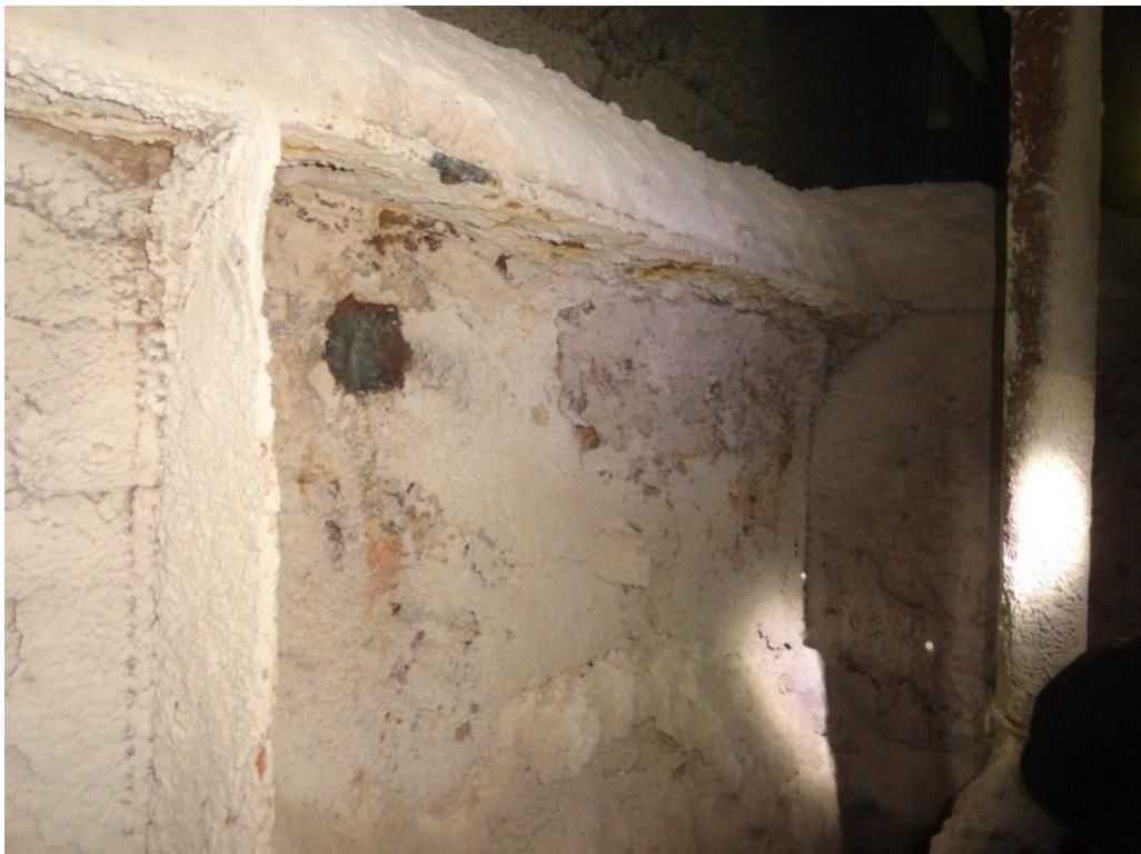
Рис 2. Отложение соли на поверхности конструкций копра высотой до 150 мм.
