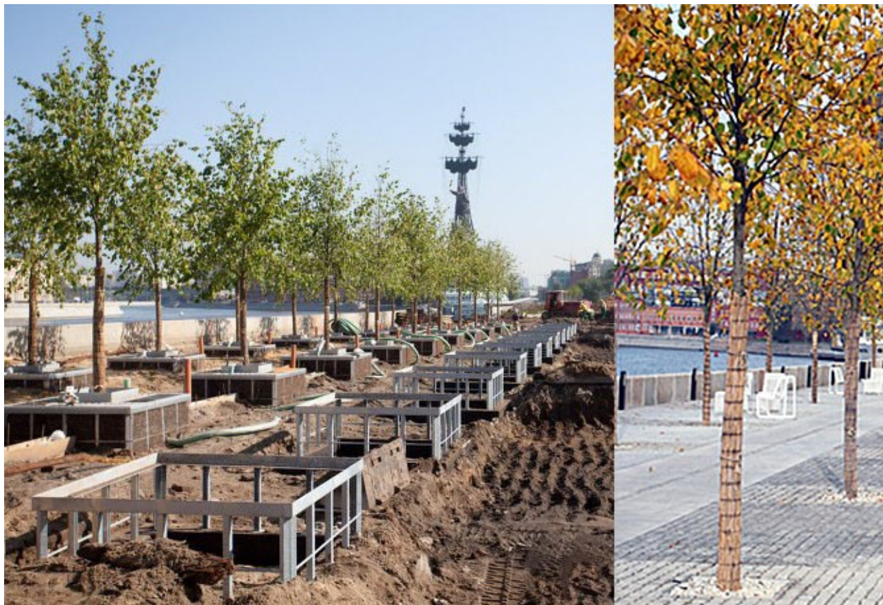
Рисунок 4 – Посадка деревьев по технологии подвешеного мощения
