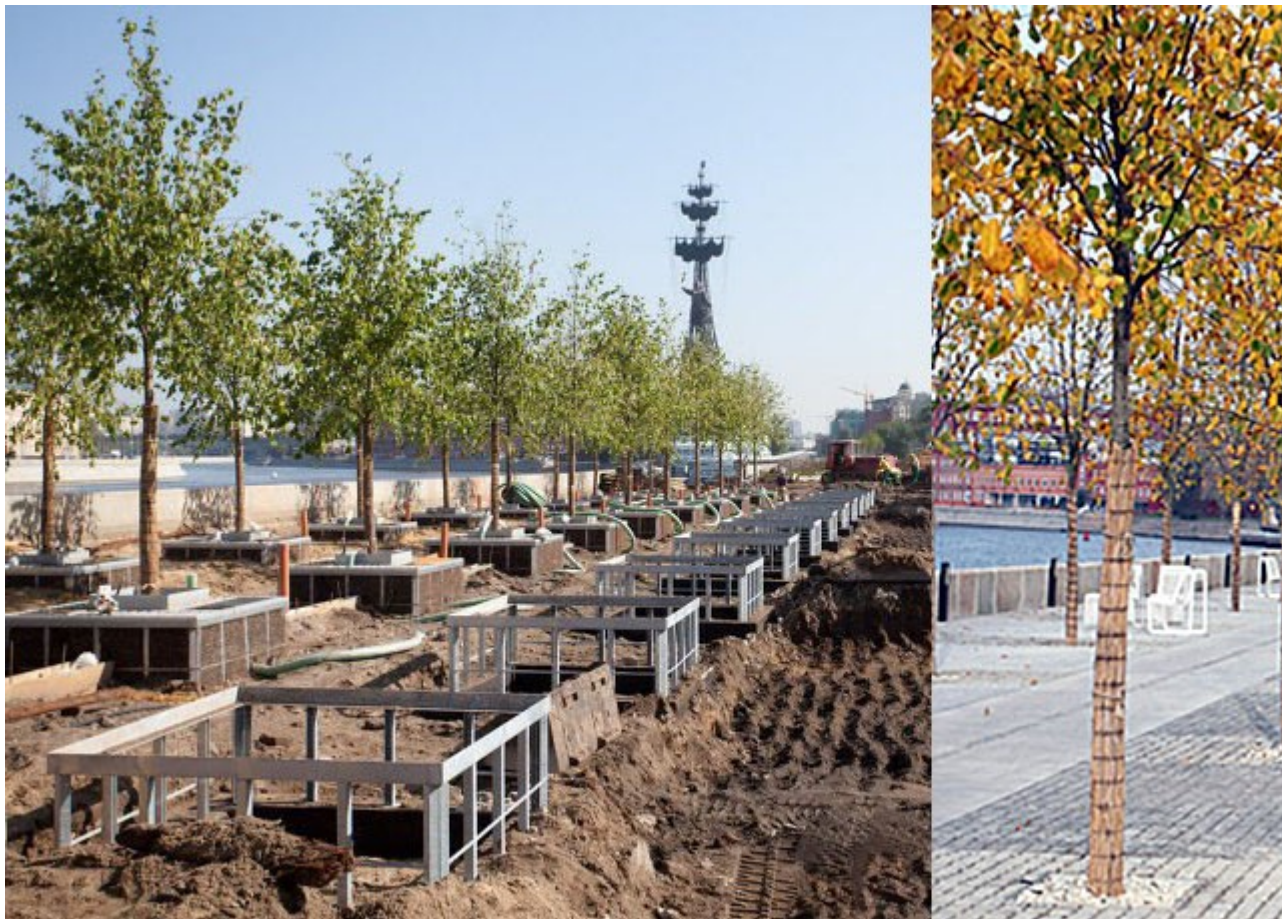
Рисунок 4 – Посадка деревьев по технологии подвесного мощения
