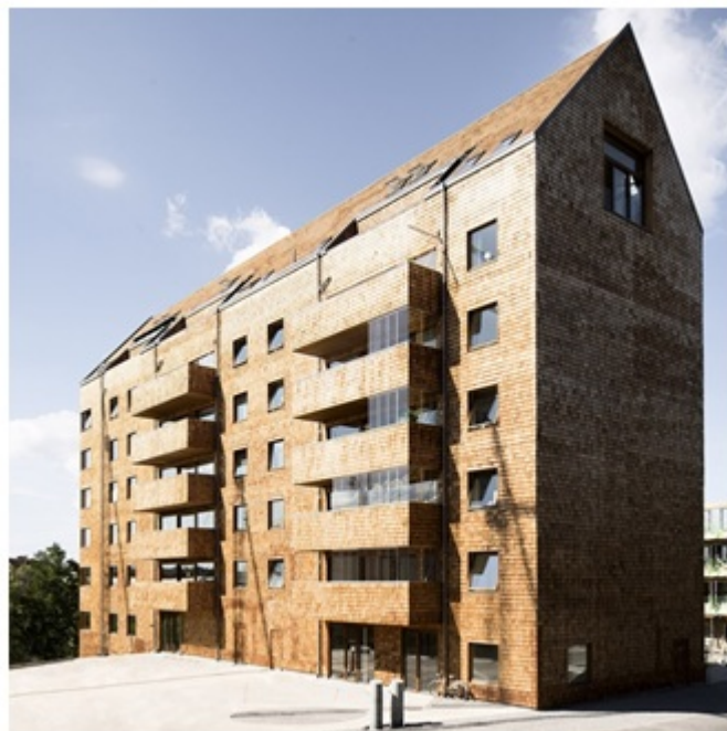
Рис. 2 - Восьмиэтажный дом высотой 26 м в Стокгольме.
