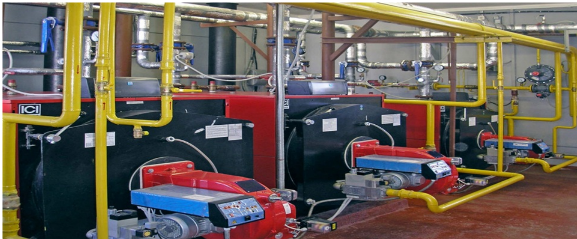
Рис. 1 - Газовая котельная.
