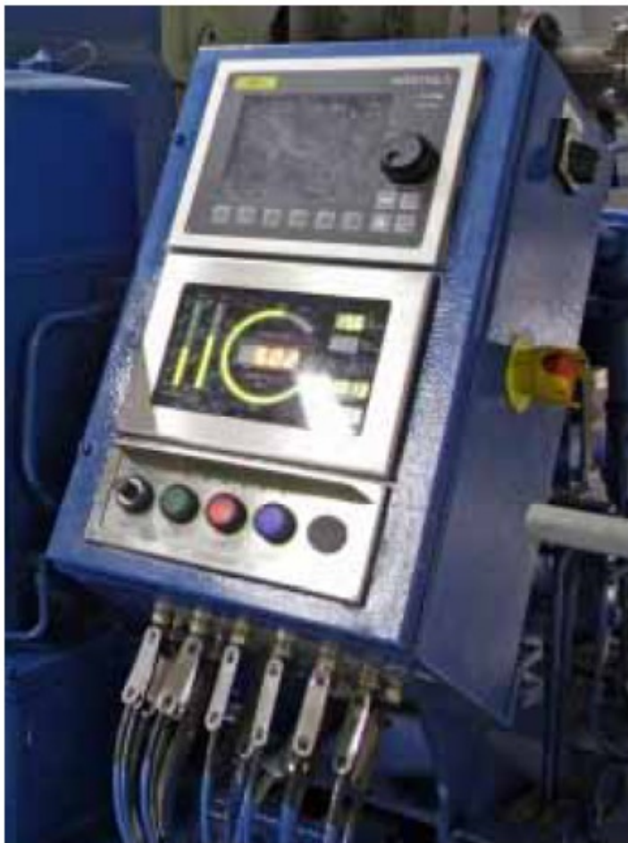
Рисунок 24 — Установка системы UNIC C3 на двигателе
