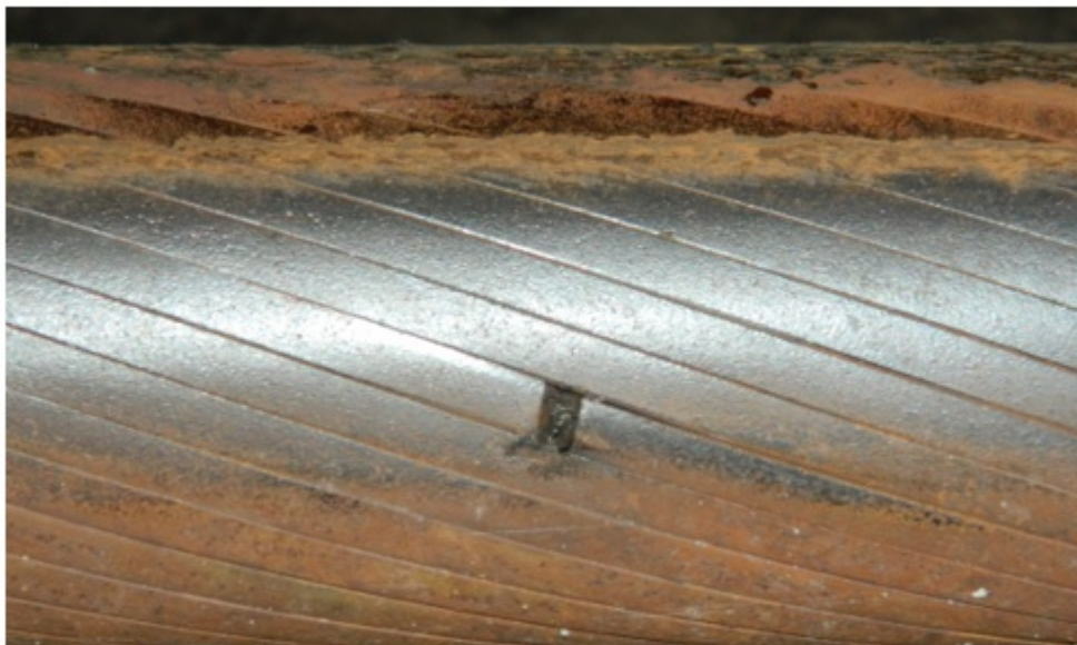
Рис. 2 Обрыв проволоки наружного слоя
