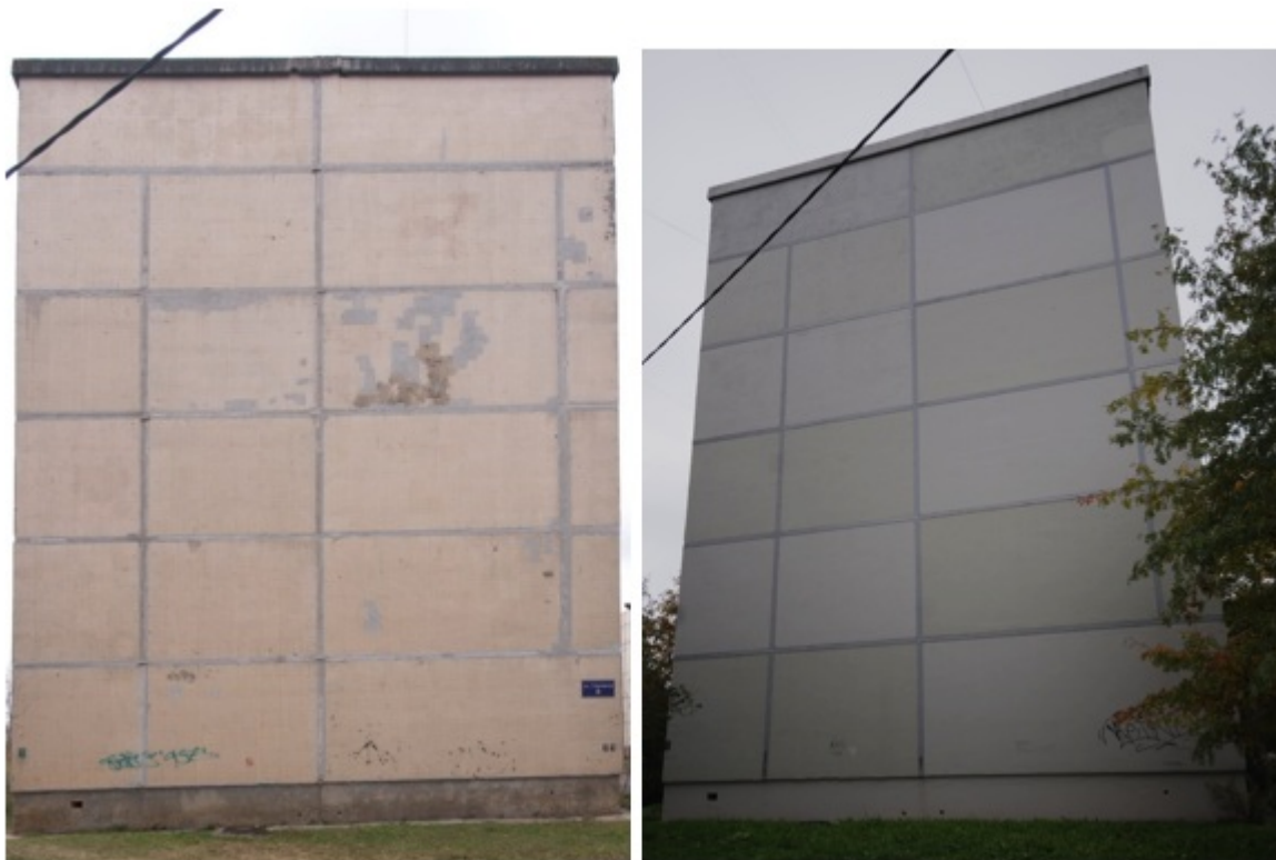
Рис. 4 — Ленинградская область, г. Пикалёво. Вид фасада до ремонта по технологии ППШ и четыре года спустя.
