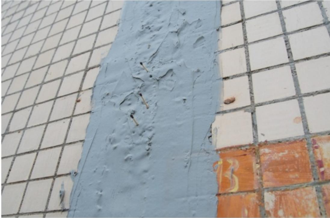
Рисунок 2 — Состояние межпанельных швов через пол года после ремонта
