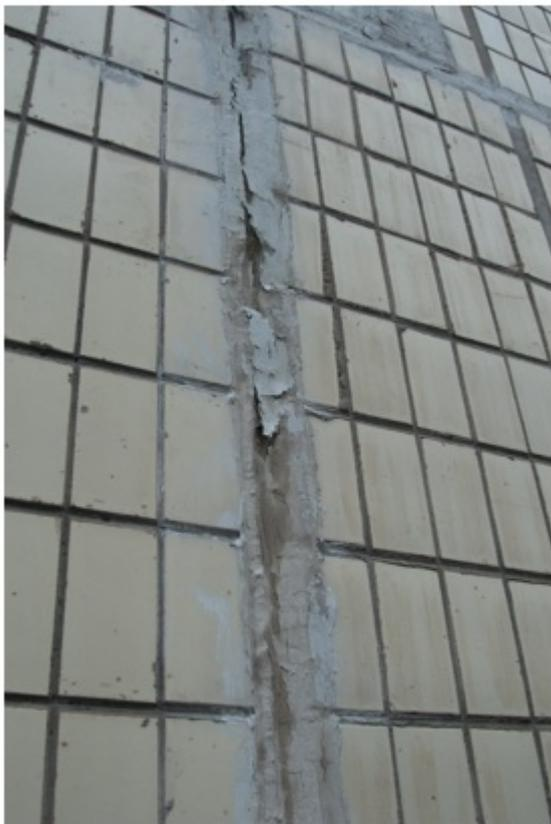
Рисунок 3 — Состояние швов через три года после ремонта
