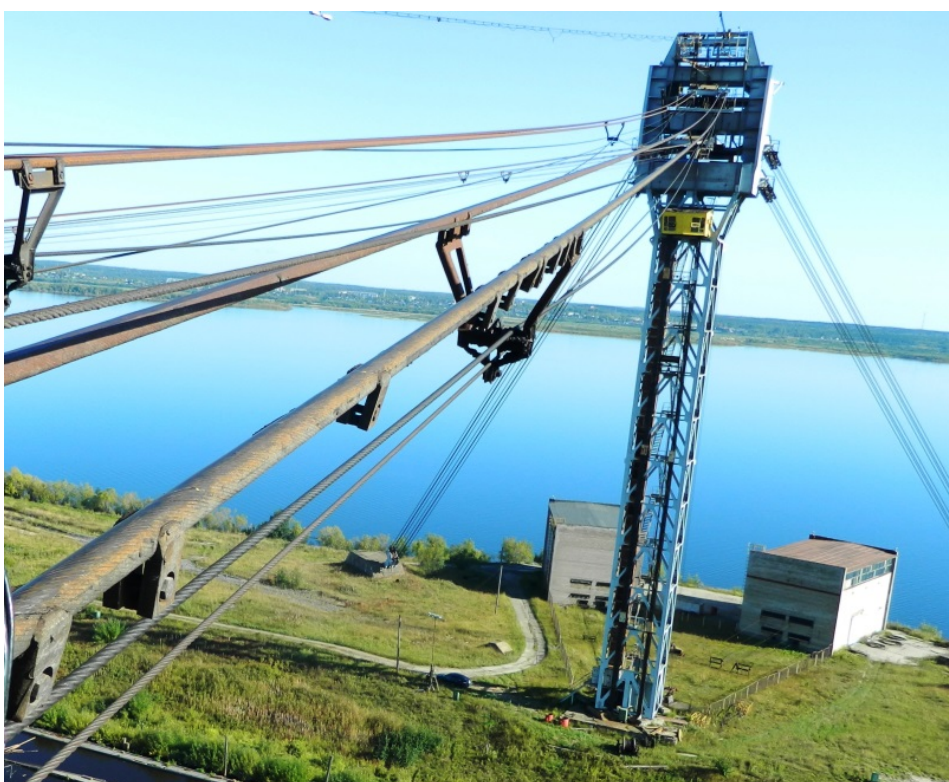
Установленный зажим в зоне пайки
