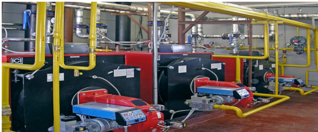
Рис. 1 - Газовая котельная.
