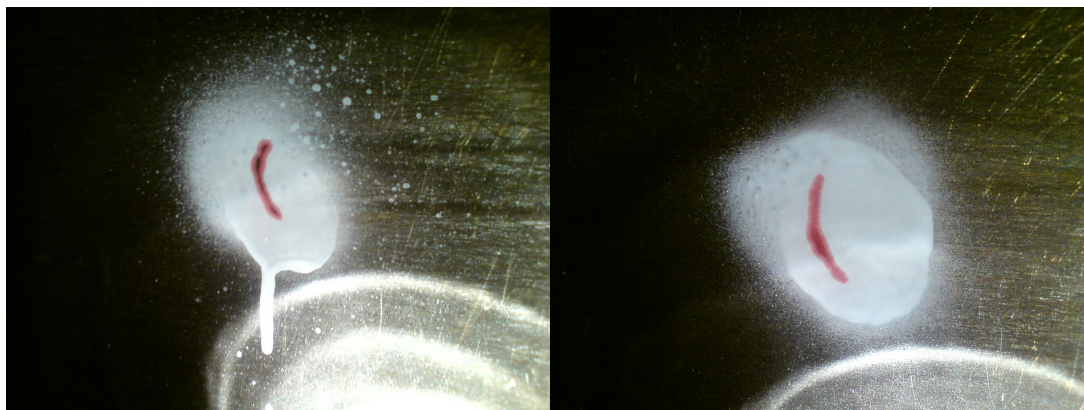
Фото 3, 4. Трещины в обечайке стерилизационных камер стерилизаторов ГК-100, выявленные цветной дефектоскопией.
