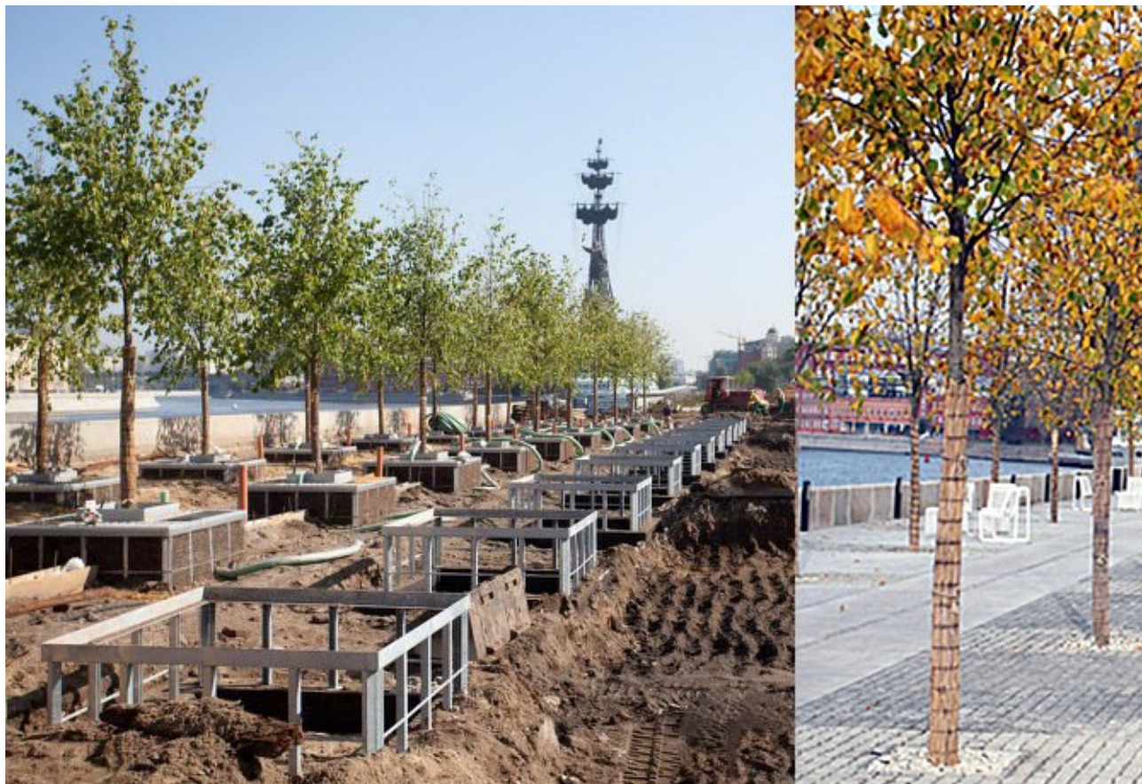
Рисунок 4 – Посадка деревьев по технологии подвешенного мощения
