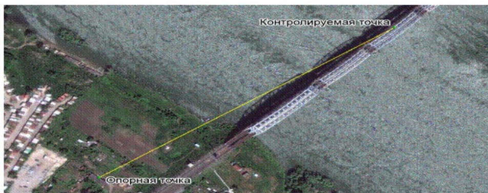
Рисунок 3. Эксплуатация системы на автомобильном мосту.
