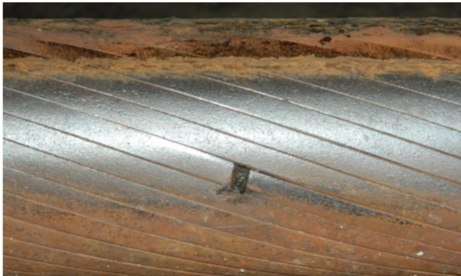
Рис. 2 Обрыв проволоки наружного слоя
